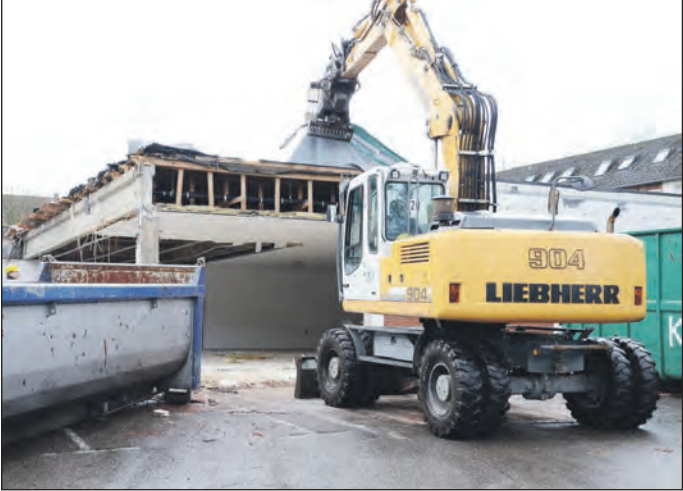
Nedrivningsarbejdet i Erikstrasse er gået igang.
